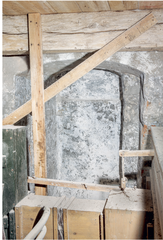
Fig. 19. \dagger Hejseluge i tårnets mellemstokværk set mod nord (s. 4627). Foto Arnold Mikkelsen 2025. – Lift hatch on the intermediate floor of the tower looking north.
