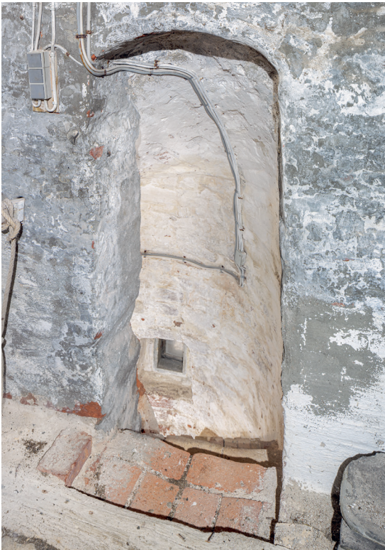
Fig. 18. Overdør i trappehus set mod syd (s. 4627). Foto Arnold Mikkelsen 2025. – Upper door of the stairwell looking south.
